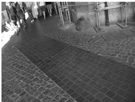
Figura 4: Piso acessível em faixa livre de Roma. Foto: Silvana Serafino Cambiagli e Oswaldo Rafael Fantini.
