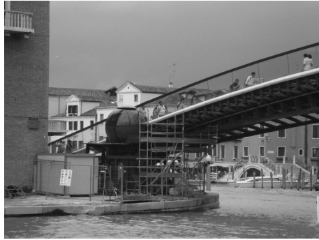
Figura 3: Adequação por equipamento de deslocamento em forma de esfera para transportar ponte em Veneza. Foto: Silvana Serafino Cambiaghi e Oswaldo Rafael Fantini.
