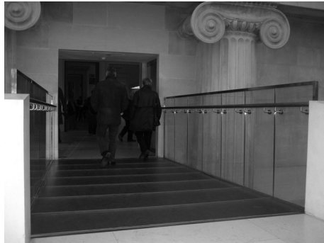
Figura 05: Ponte de ligação entre duas alas do British Museum de Londres - Inglaterra. Foto: Núcleo Pró-Acesso/UFRJ.
